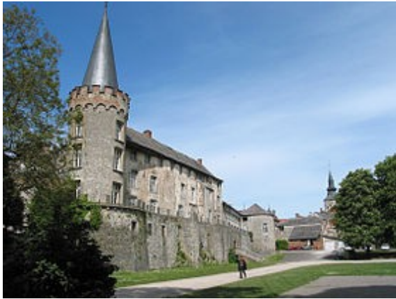
Le château de Florennes (également connu comme Château de Beaufort) dont la construction a débuté au IXème siècle
